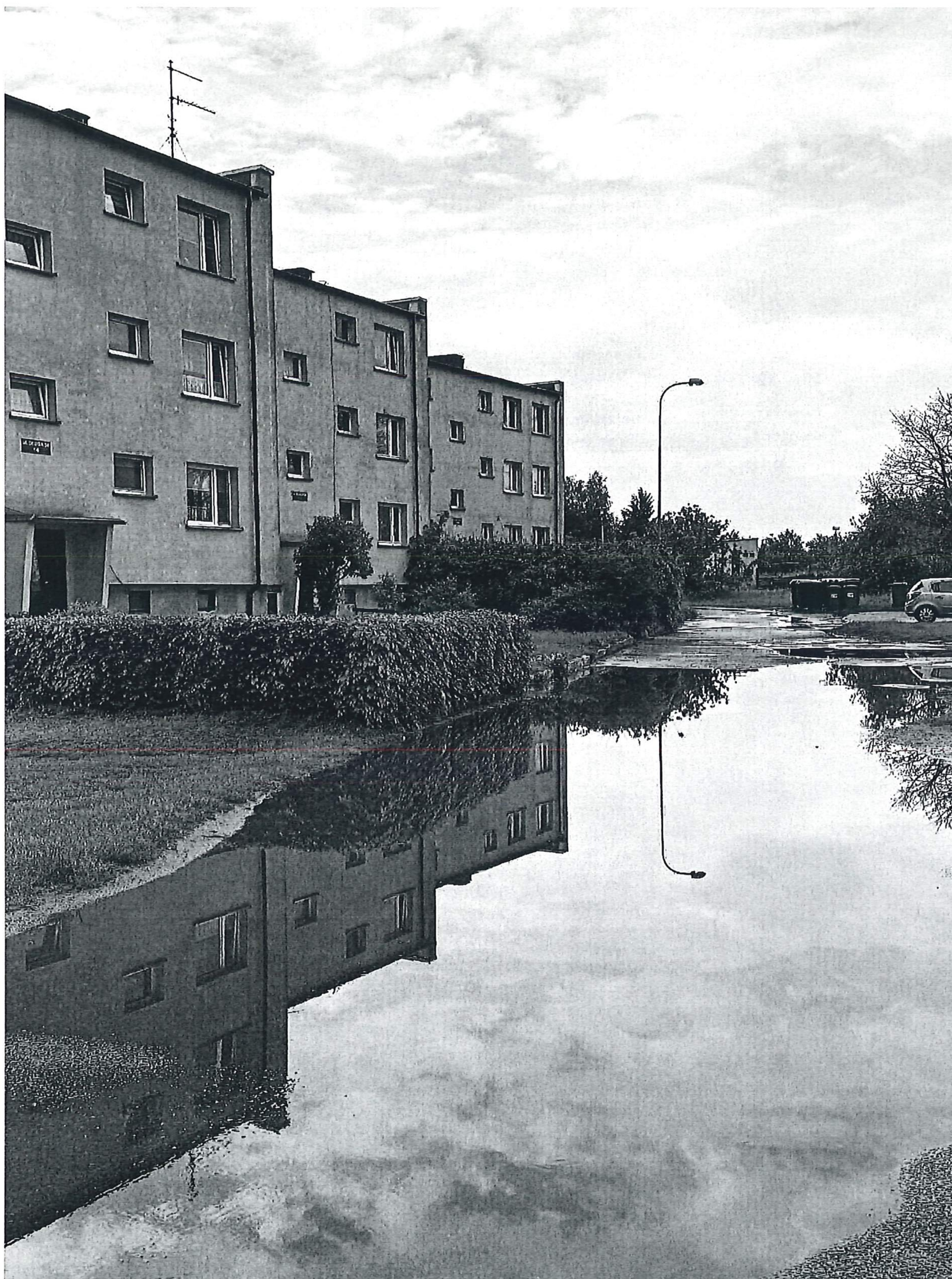
Stojąca woda przy blokach na ul. Długiej 34
