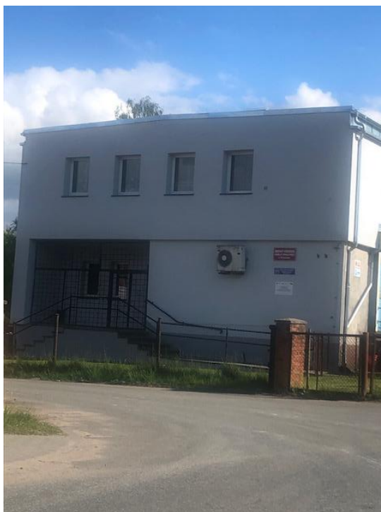
Budynek Gminnego Ośrodka Pomocy Społecznej po termomodernizacji
