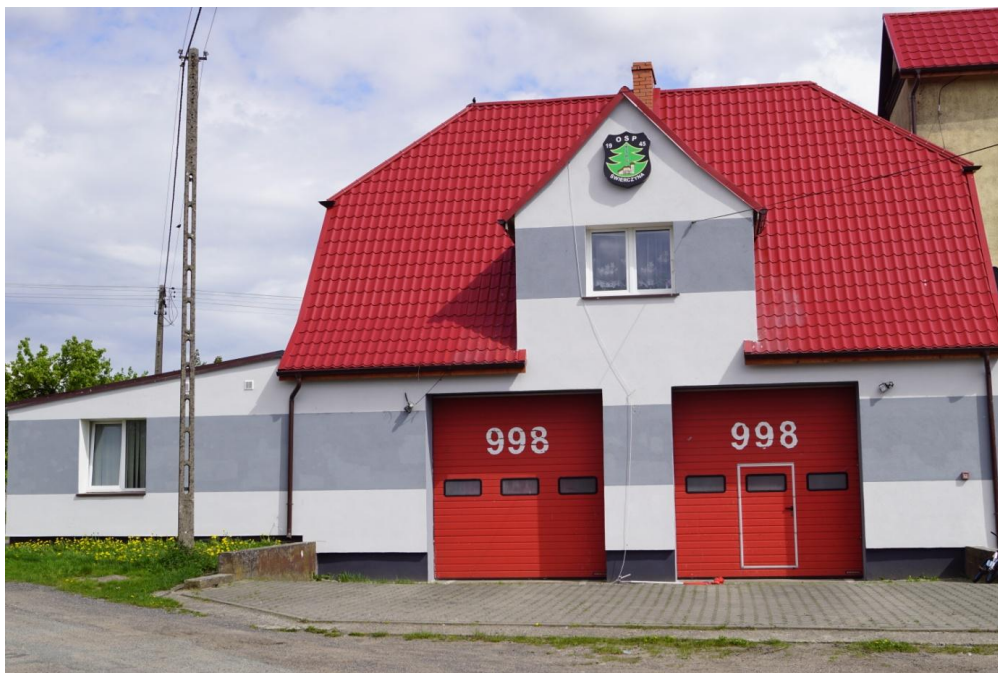
Strażnica w Świerczynie po remoncie elewacji.
