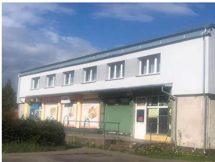
Budynek Gminnego Ośrodka Pomocy Społecznej po termomodernizacji
